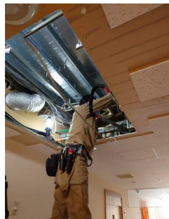
R4 郷和GHPエアコン入替工事
